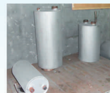
ГРЯЗЕВЫЕ ФИЛЬТРЫ СИСТЕМ ТЕПЛОСНАБЖЕНИЯ
