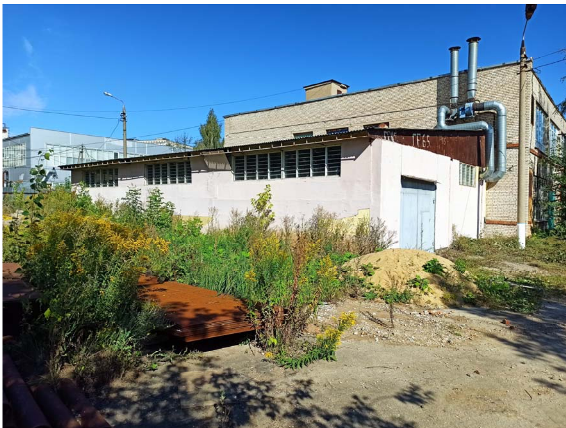
Рисунок 4.3 – Площадка изысканий частично застроена
