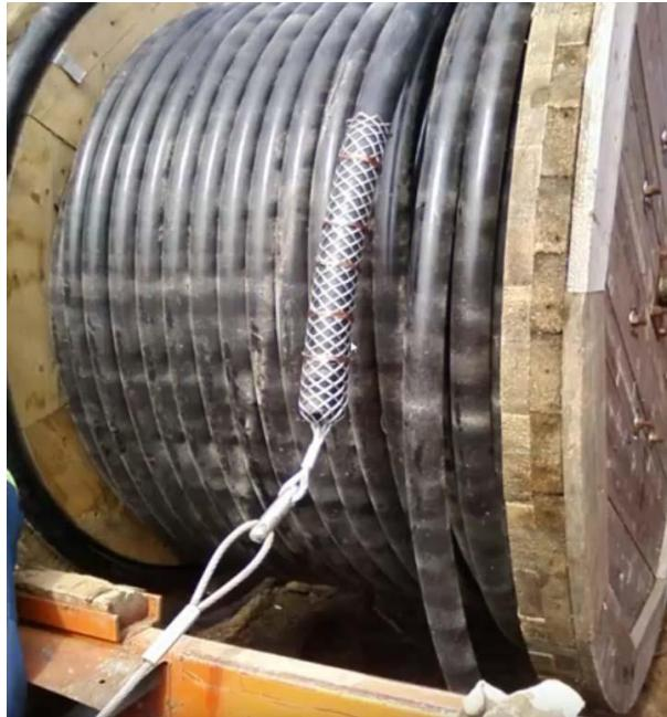
Рисунок 1 – Протяжка кабеля с использованием кабельного чулка
